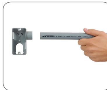
i) Fixe o tubo ElectroAmanco nas abraçadeiras até a próxima caixa a instalar.
