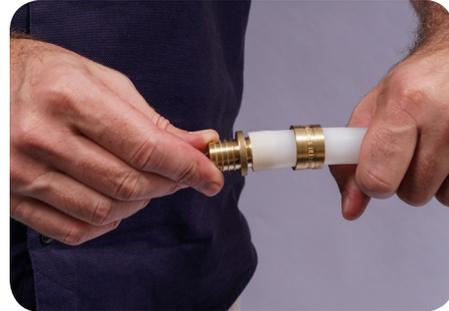
c) Deslize o anel sobre a bolsa com o auxílio da ferramenta de montagem.
