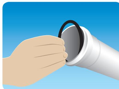
d) Aplique uma camada de Pasta Lubrificante Amanco na ponta do tubo e na parte visível do Anel de Vedação.
