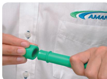
i) Após a termofusão da conexão com o tubo, segure firme durante 20 a 30 segundos. Durante um intervalo de aproximadamente 3 segundos, existe a possibilidade de alinhar a conexão em até 15° (não gire).
