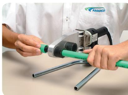
g) Retire simultaneamente o tubo e a conexão do termofusor quando decorrer o tempo mínimo de aquecimento, conforme tabela de tempo de termofusão a seguir.
