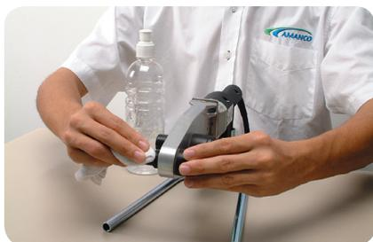
b) Corte os tubos com a tesoura especial, eliminando as rebarbas.
